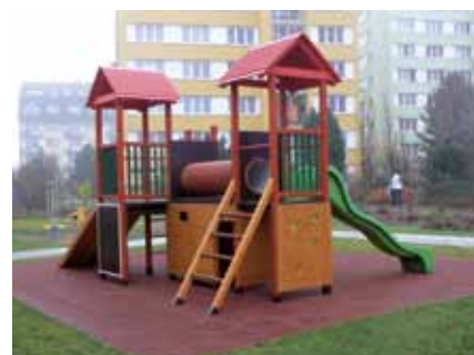
Město Strakonice / Rekonstrukce venkovního areálu Mateřské školy Stavbařů / 1 834 461 Kč / 1 375 846 Kč
